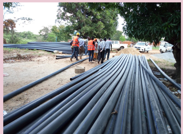
Wajumbe wa Kamati ya Fedha wakikagua mabomba ya mradi wa usambazaji maji Kondoa Mjini.
