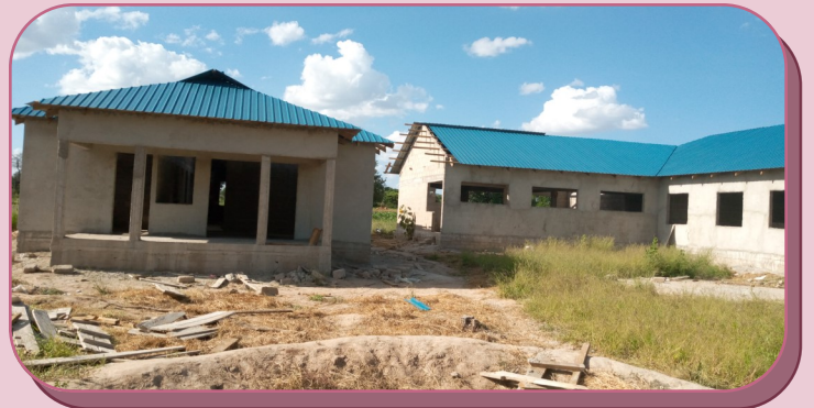
Mwonekano wa baadhi ya majengo ya Kituo cha Afya Kingale kinachoendelea kukamilishwa baada ya Serikali ya awamu ya tano kutoa shilingi milioni 400 kwa ajili ya ujenzi wa
