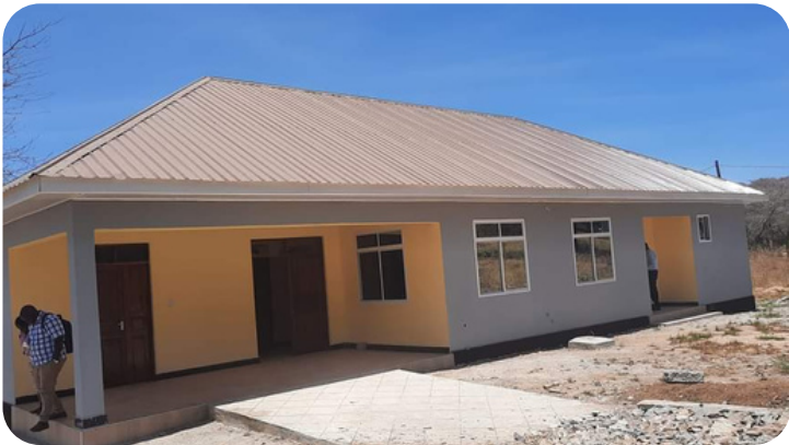
Jengo la mochwari Hospitali ya Mji
